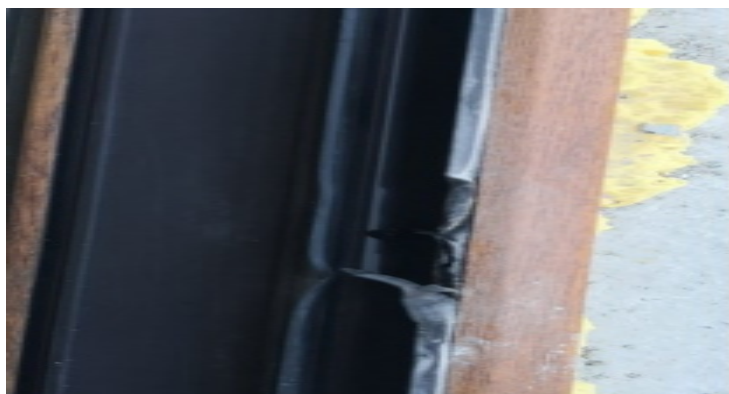
Consecinte ale unui montaj necorespunzator
