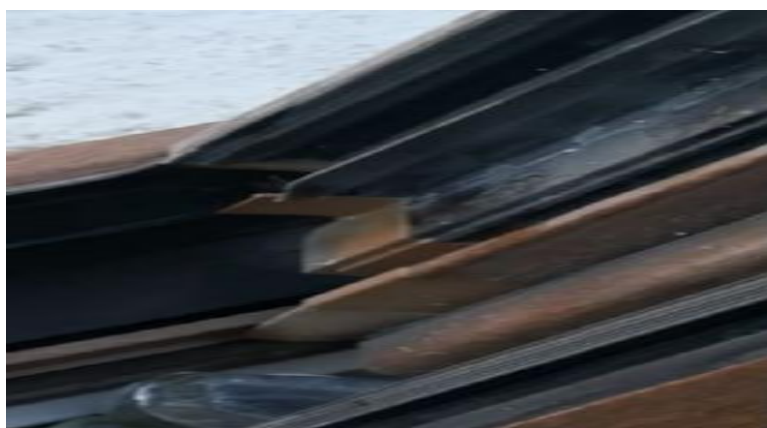
Ccv armonica fara reglaj si calata necorespunzator
